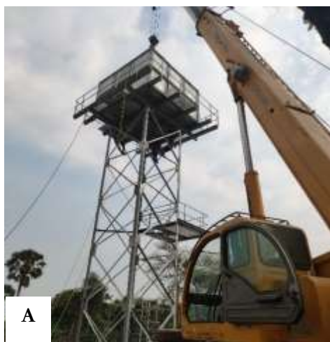
Imagens 1: Ilustração de depósito elevado (betão, e metálico) e casa de gestão (A e D), depósito apoiado e casa das bombas (B), montagem da estrutura do depósito elevado e o painel solar (C e D). Fonte de captação e casa de comando (E), e fontanário (F)
