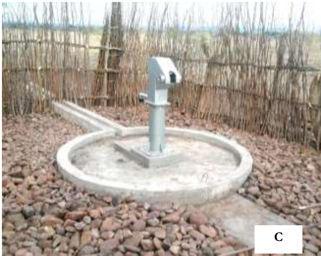
Imagens 6: Fiscalização de trabalhos de construção de furos de abastecimento de água, a saber, Análise de temperatura, TDS e Condutividade (A) Ensaio de caudal de furo (B). Montagem de bomba manual Afridev (C), Inauguração de Fonte com bomba manual (D).
